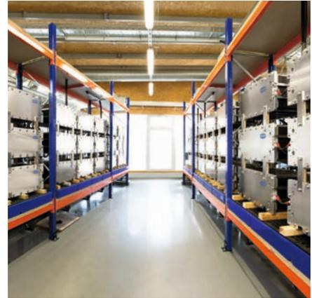
Der Redox-Flow-Großbatteriespeicher auf dem Gelände des Fraunhofer ICT in Pfinztal: Die Pilotanlage ist mit Stacks von Schmalz ausgestattet.
