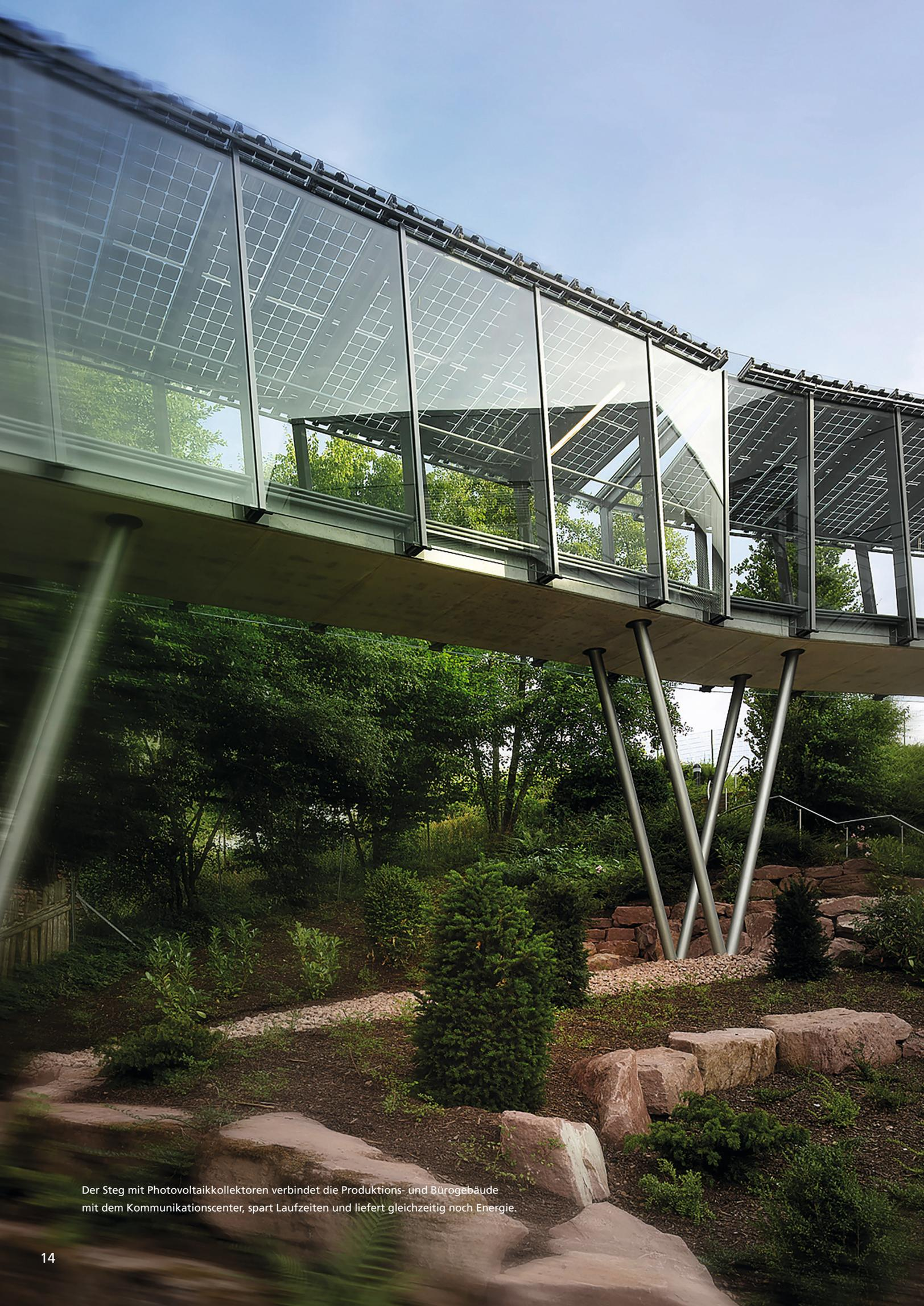
Der Steg mit Photovoltaikkollektoren verbindet die Produktions- und Bürogebäude mit dem Kommunikationscenter, spart Laufzeiten und liefert gleichzeitig noch Energie.
